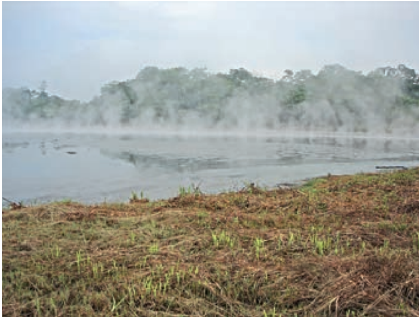
Pileta API donde se depositaban las aguas de producción antes de ser vertidas. Fuente: Martí Orta-Martínez. FECONACO.
